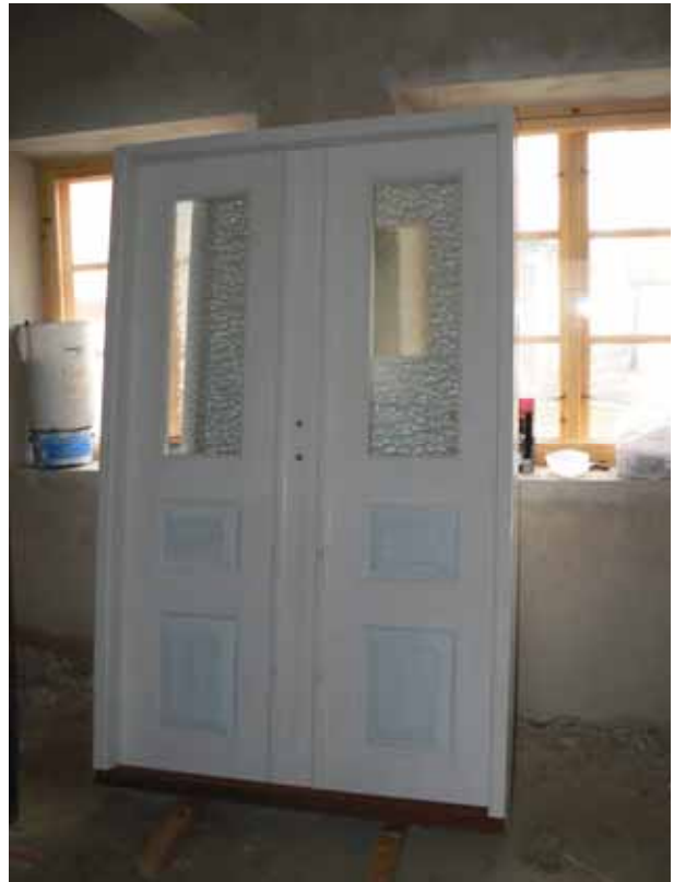
Figur 17 och 18. Den västra boningslängans trädgårdsfasad samt en av de två nytillverkade dörrarna.
