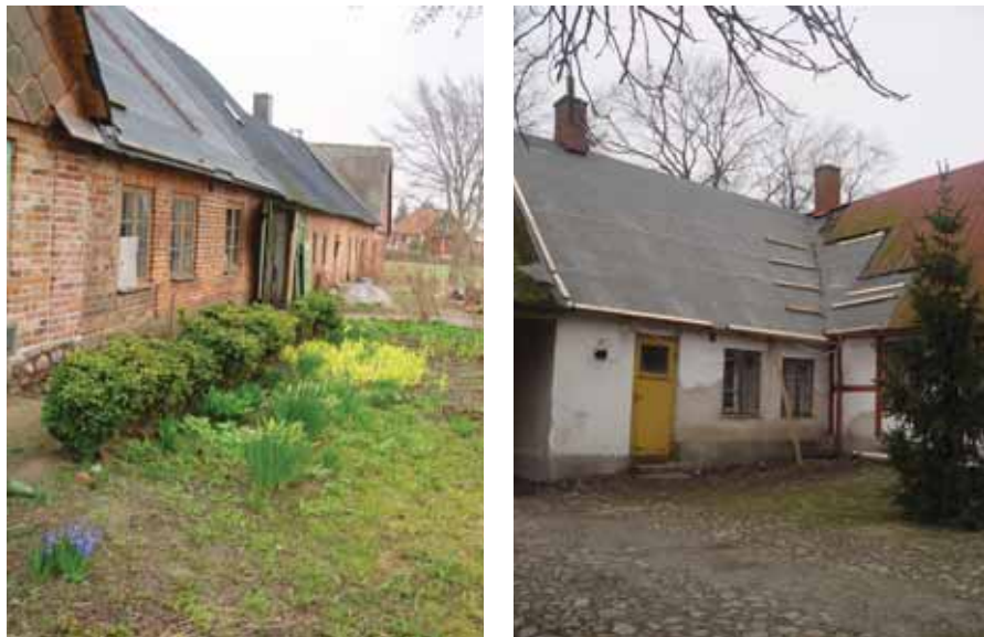
Figur 13 och 14. Byggnaden väster om portgången före genomförda renoveringsarbeten.
